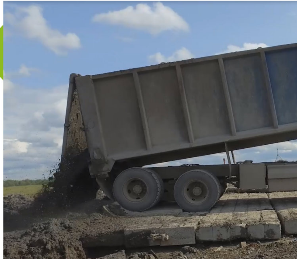
Dépôt du stablex dans une cellule de placement creusée dans le sol
