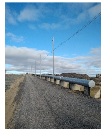
La ligne de vapeur sèche sera installée sur des blocs au sol pour plus d'efficacité.
