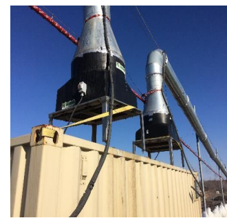
Le système de neutralisant d'odeurs à la vapeur sèche est plus performant l'hiver en prévenant notamment le gel des conduits.
