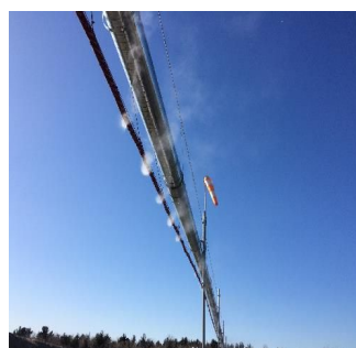
Le système de neutralisant d'odeurs à la vapeur sèche est plus performant l'hiver en prévenant notamment le gel des conduits.
